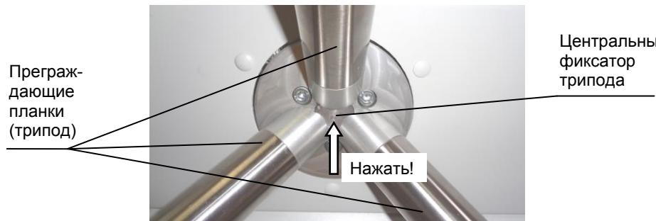
Рис.3 Место расположения центрального фиксатора трипода
